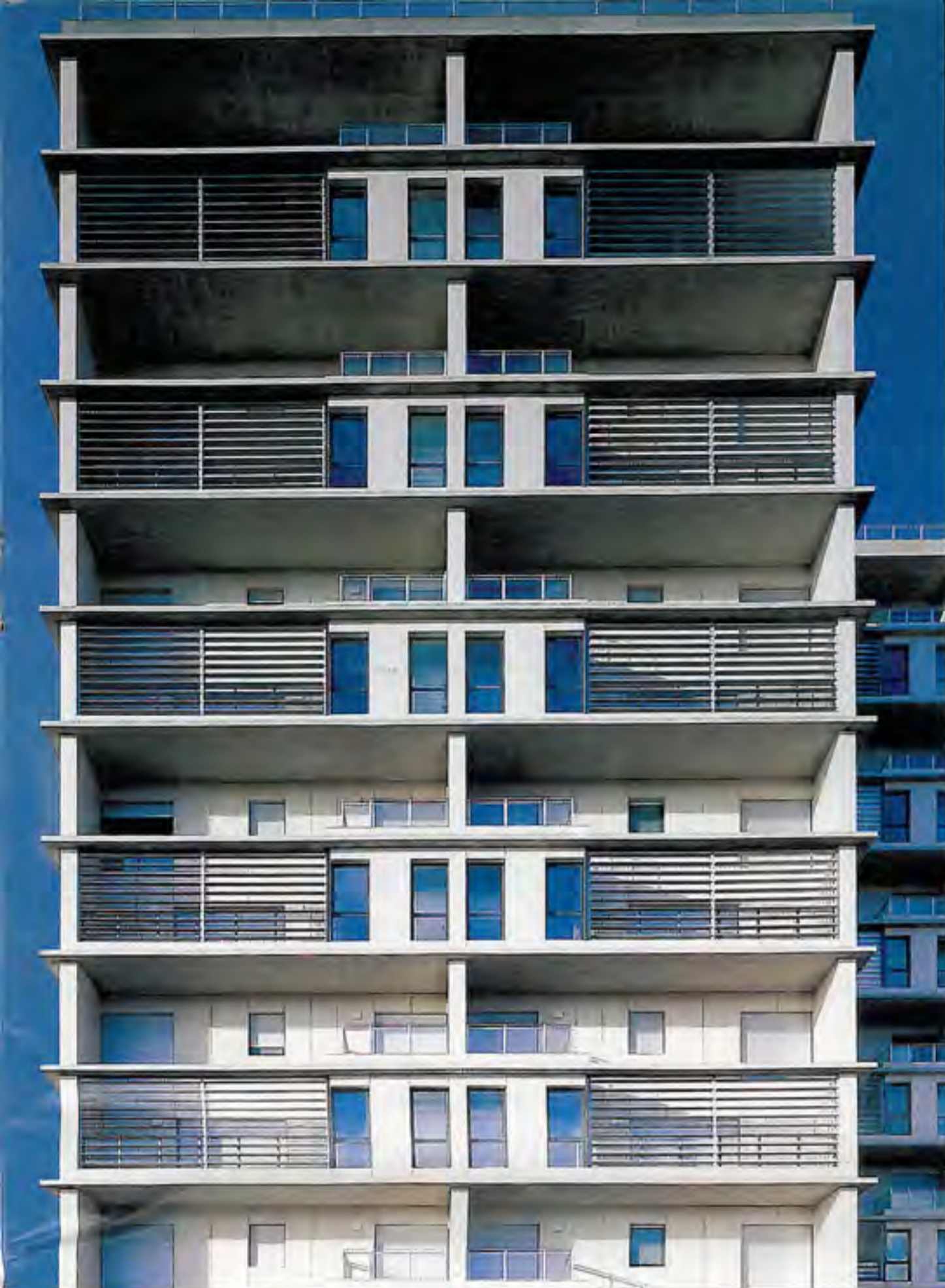
Destaque da fachada, com os terraços-varanda de duplo pé-direito em primeiro plano.
